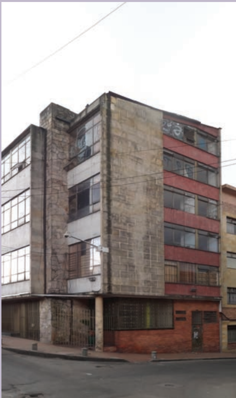
Edificio donde funcionaba el Taller 4 Rojo. Calle 12 con carrera 1era., Bogotá.
